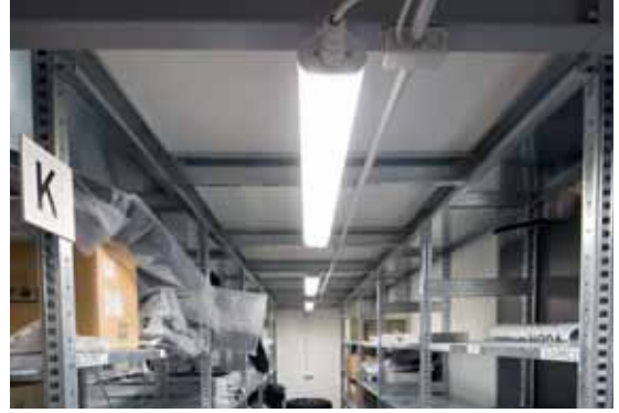
MAGAZZINO / WAREHOUSE | Repubblica Ceca
